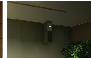
스마트 에어센서 실내 공기질 실시간 모니터링
